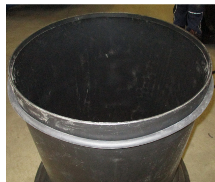
Rolldichtung über Domschacht schieben
