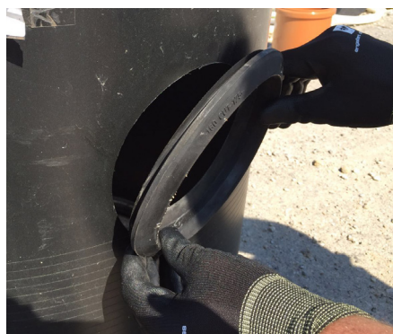
Zulaufdichtung monieren - Außenansicht
