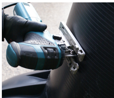
Domschacht bei Bedarf kürzen
