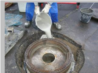
9. Verfüllen des aufgestemmtm Fugenspalts mit Gießmörtel
