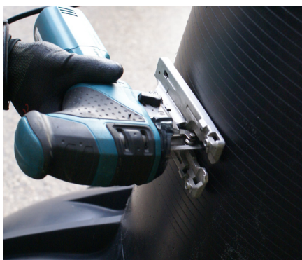
Domschacht bei Bedarf kürzen
