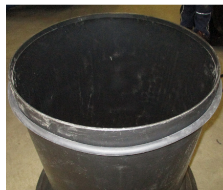
Rollldichtung über Domschacht schieben
