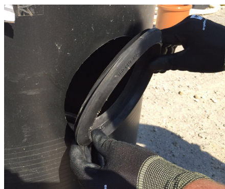
Zulaufdichtung monieren - Außenansicht
