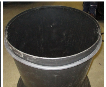
Rollringdichtung über Domschacht schieben
