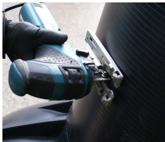
Domschacht bei Bedarf kürzen
