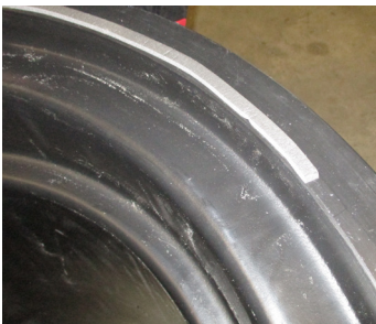
Flachdichtung am Teleskopdomschacht
