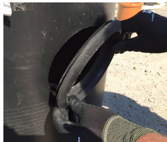
Zulaufdichtung montieren - Außenansicht
