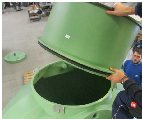
Schritt 10: Domschacht-Aufsatz auf Trinkwassertank stecken. (Rundschnurdichtung sitzt zwischen Tank und Aufsatz!!)
