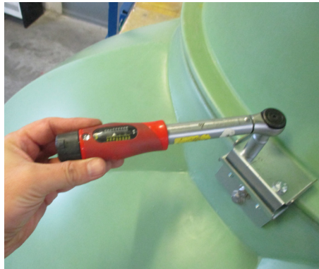
Schritt 13: Sechskantschrauben mit 80Nm anziehen.
