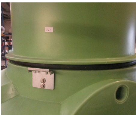
Positionierter Domschacht Aufsatz
