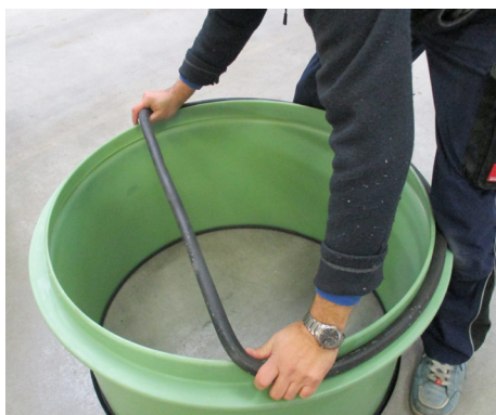
Schritt 7: Rundschnurdichtung auf Unterseite Domschacht Aufsatz stecken.
