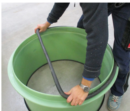
Schritt 7: Rundschnurdichtung auf Unterseite Domschacht Aufsatz stecken
