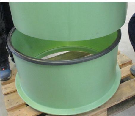
Schritt 5: Teleskopdomschacht vom Aufsatz herunterziehen
