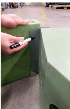
Schritt 4: Es sind die Bohrungen des Befestigungswinkels auf die Flügelemente zu übertragen.
