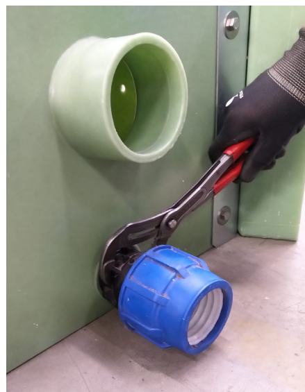
Schritt 17: ASKV-Verschraubung mit der Wasserpumpenzange festziehen.
