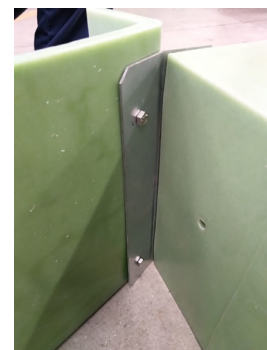
Schritt 6: Sechskantschrauben M8 x 25mm zur Befestigung der Flügelemente durch die Bohrungen schieben.
