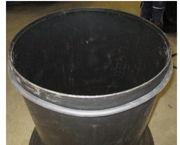
Rollringdichtung über Domschacht schieben
