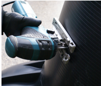
Domschacht bei Bedarf kürzen
