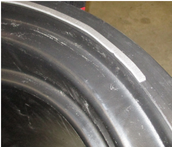
Flachdichtung am Teleskopdomschacht
