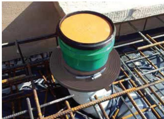
AD 8 mm bis einschließlich 315 mm, druckdicht bis 5 bar
