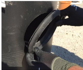
Zulaufdichtung montieren - Außenansicht
