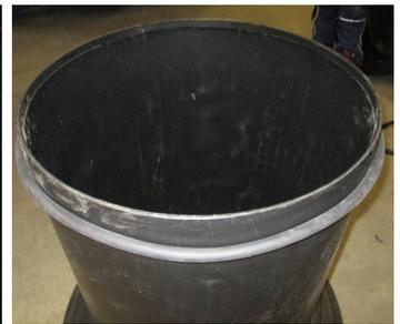
Rollringdichtung über Domschacht schieben
